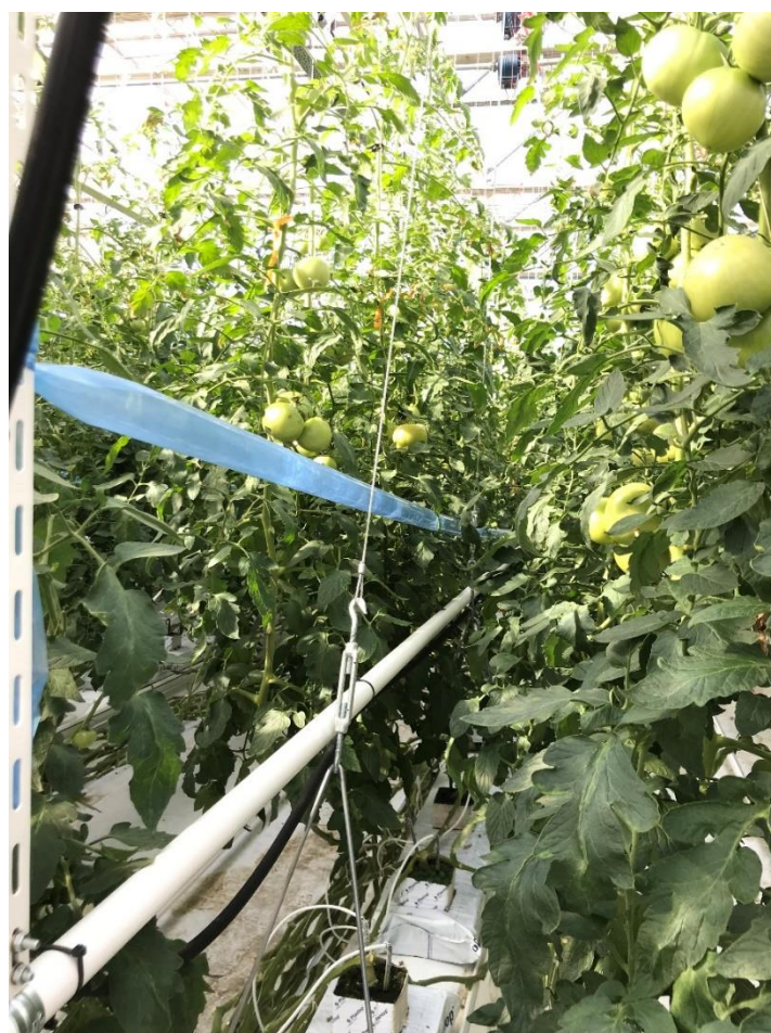
写真2 子ダクトの設置状況
